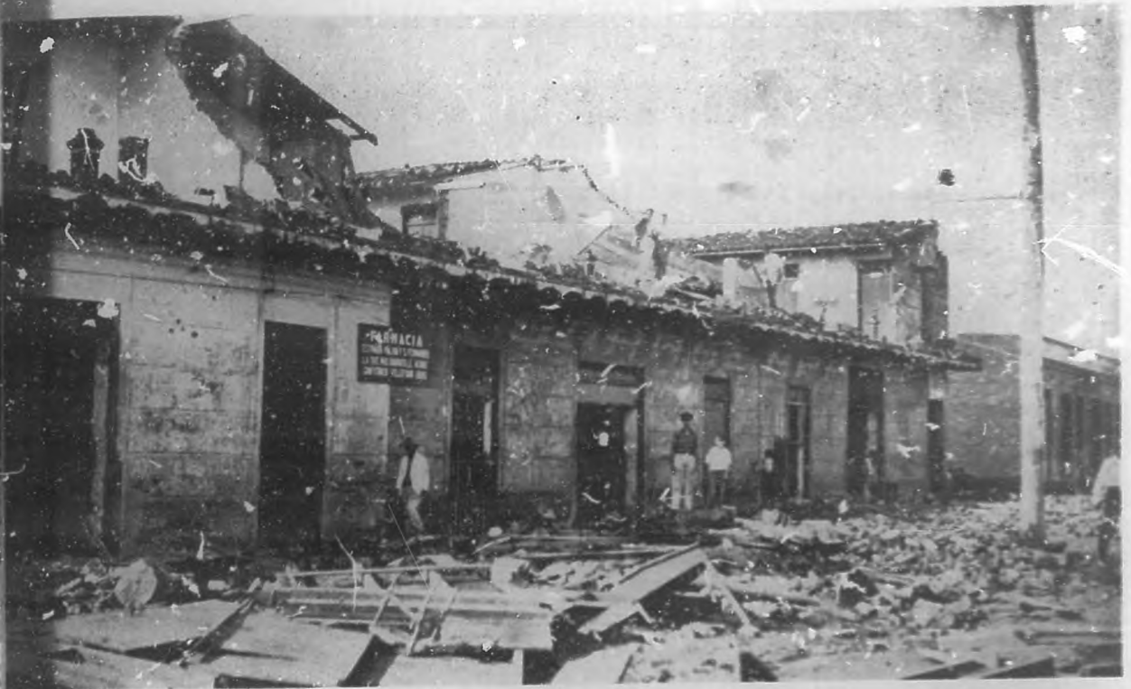
El garage "Marina" y los demás edificios de la barriada, conservaron sus paredes en pie a despecho de la furia del viento. Pero los techos volaron como si hubieran sido simples estructuras de cartón.
