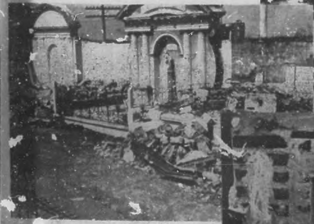
El panteón de los Hurtado, una de las más importantes edificaciones de la necrópolis camagüeyana, fue destruido por la multitud de escombros en que fueron muchas tumbas por la ferozidad de un viento de 155 millas de velocidad.
