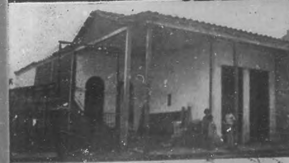
Muchas de las casas de Morón sufrieron desperfectos. La foto muestra una casa, cuyas paredes fueron completamente pulverizadas por la violencia del meteoro.
