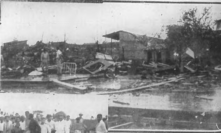
RESTOS DE OTRA VIVIENDA HUMILDE.—Todo destruido, todo a la intemperie, y sobre el desnudo piso, camas, restos de escaparates y mil otras pertenencias familiares completamente destruidas.
