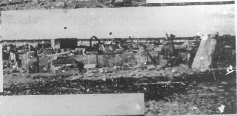
Sobre estas ruinas, lejos de concreto, se levantó el edificio de la parroquia de Peñón, uno de los más bonitos que construyeron en Santa Cruz del Sur. El hecho puede dar cuenta de la magnitud de la catástrofe, cuando que no hay ni siquiera señal. Es lo que fue el templo y el huerto dedicado a la curación del pueblo.
