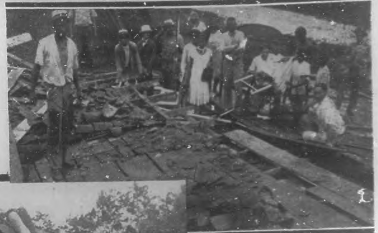
En Florida también produjo efectos el meteoro. La foto muestra varias de las casas que fueron destruidas por la violencia del viento.
